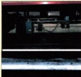
enregistrement numérique de l'état de surface des rails à 300 km/h (précision 5/10 mm)
