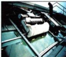
Nettoyage automatique des verrières de l'aéroport CDG par robot
